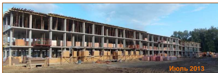
Ведется активное строительство жилого комплекса. Корпуса, часть площадей которых приобретены в фонд, подготавливаются к монтажу кровли.
