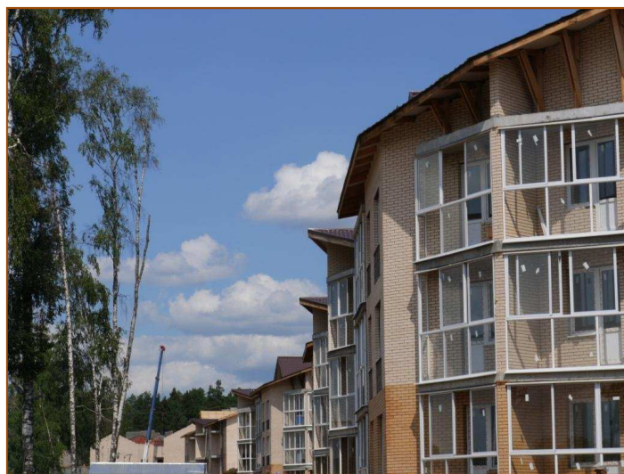
По состоянию на июль 2013 г. – технические условия на канализование и водоснабжение жилого комплекса выполнены в полном объеме. Корпуса готовятся к сдаче в эксплуатацию.
